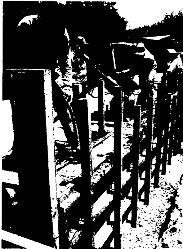
Foto 4.- Vaciado y vibrado de pantalla de muro de contención.
